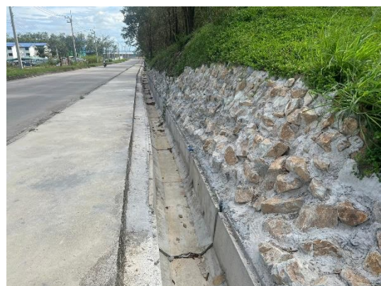
รูปที่ 5 ระบบระบายน้ำฝนของโครงการ
