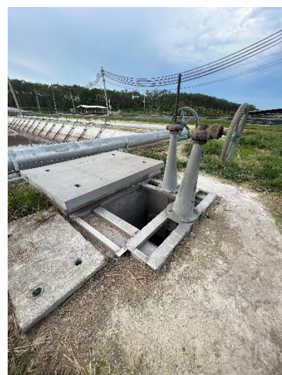
รูปที่ 6 ประตูน้ำปิด-เปิด ควบคุมการระบายน้ำเสียจากโรงงาน
