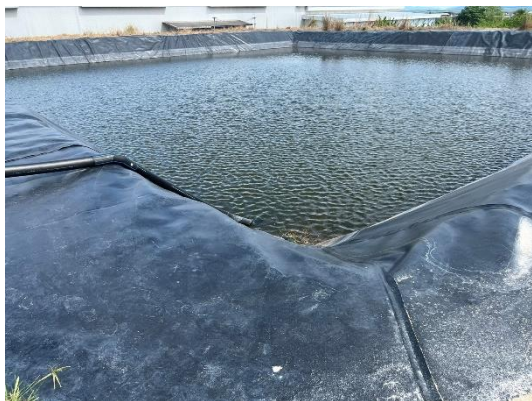
รูปที่ 10 การปู HDPE บริเวณบ่อพักน้ำทิ้ง
