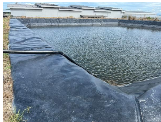
รูปที่ 10 การปู HDPE บริเวณบ่อพักน้ำทิ้ง
