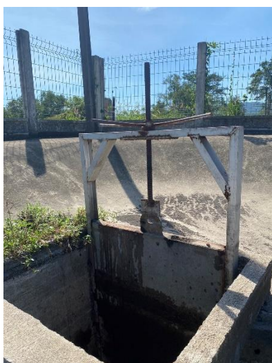
รูปที่ 6 ประตูน้ำปิด-เปิด ควบคุมการระบายน้ำเสียจากโรงงาน
